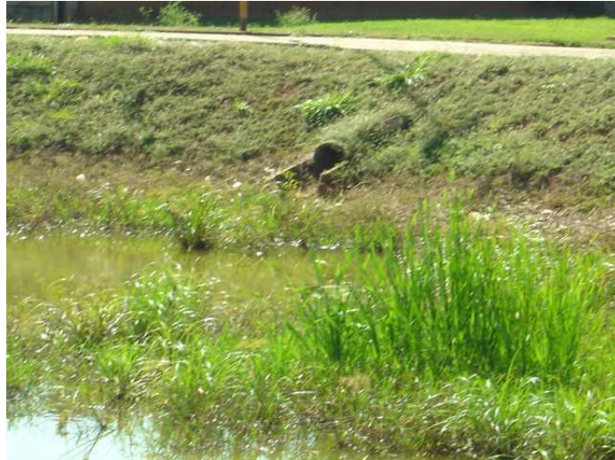
Entrada das águas pluviais (sub-bacia G) no piscinão
