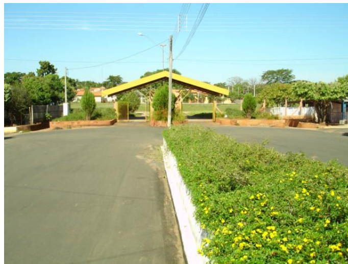
Duas canaletas superficiais (lado esquerdo e direito) de captação de águas pluviais (sub-bacia F)
