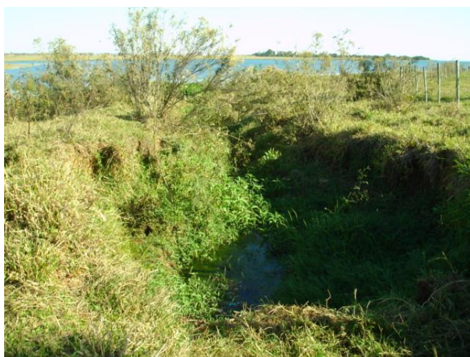
Saída das águas pluviais, vindos do piscinão, com 1,0m de diâmetro, lançados num dos braços do rio Paraná.
