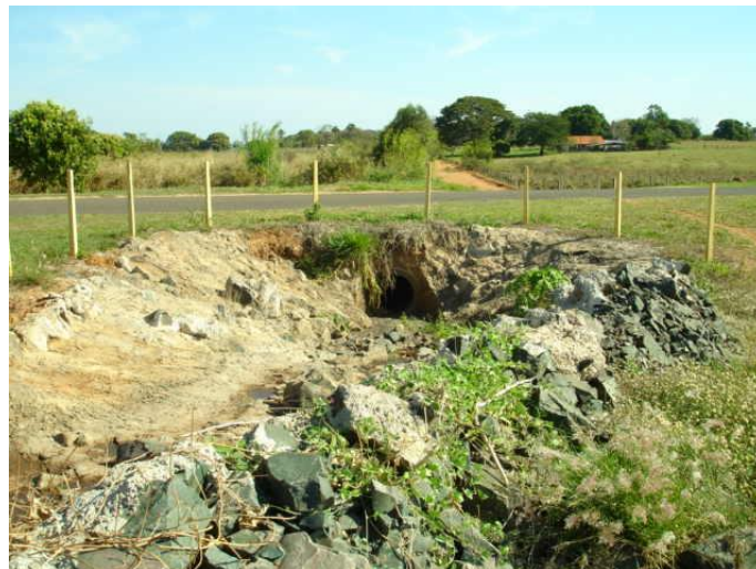
Saída das águas pluviais, em terreno natural, com passagem sob a rodovia, sub-bacia C
