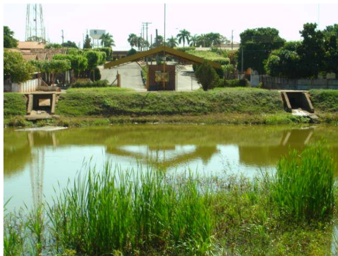
Entrada das águas pluviais (sub-bacia F) no piscinão
